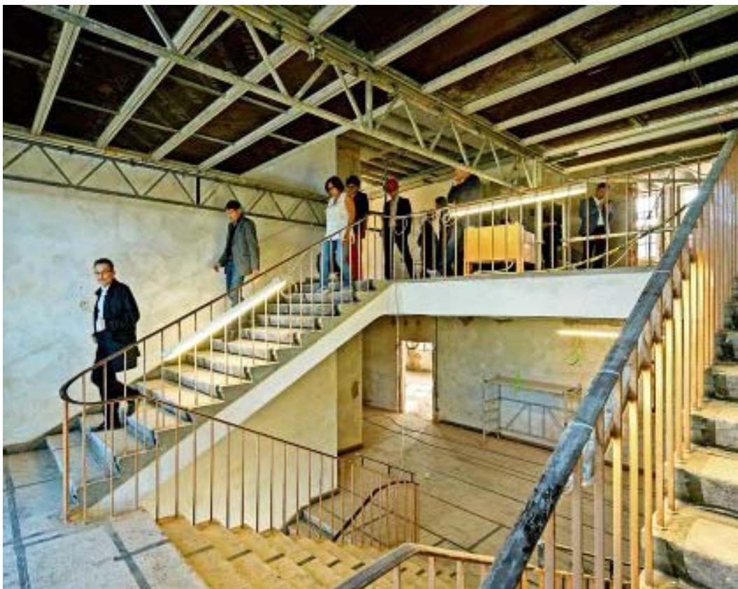
Rundgang im Goethe-Gymnasium: Horst Fischer (links) führt Gäste über die Baustelle
